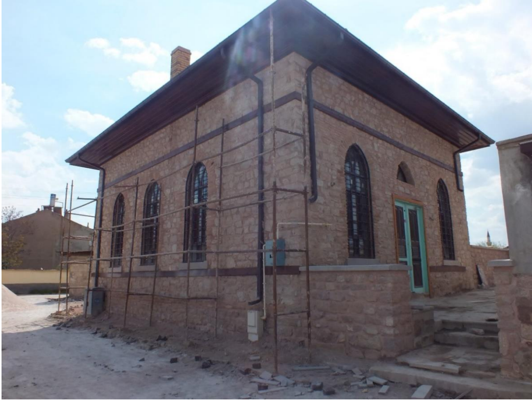
Fotoğraf 9: Hacı Ömerler Camii Kuzeydoğu Cephe Görünüşü.
