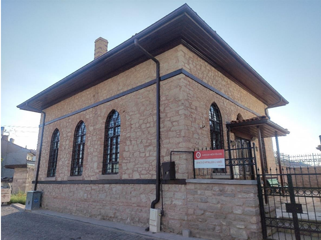
Fotoğraf 10: Hacı Ömerler Camii Kuzeydoğu Cephe Görünüşü.
