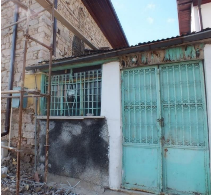
Fotoğraf 13: Hacı Ömerler Camii Avlu Görünüşü.
