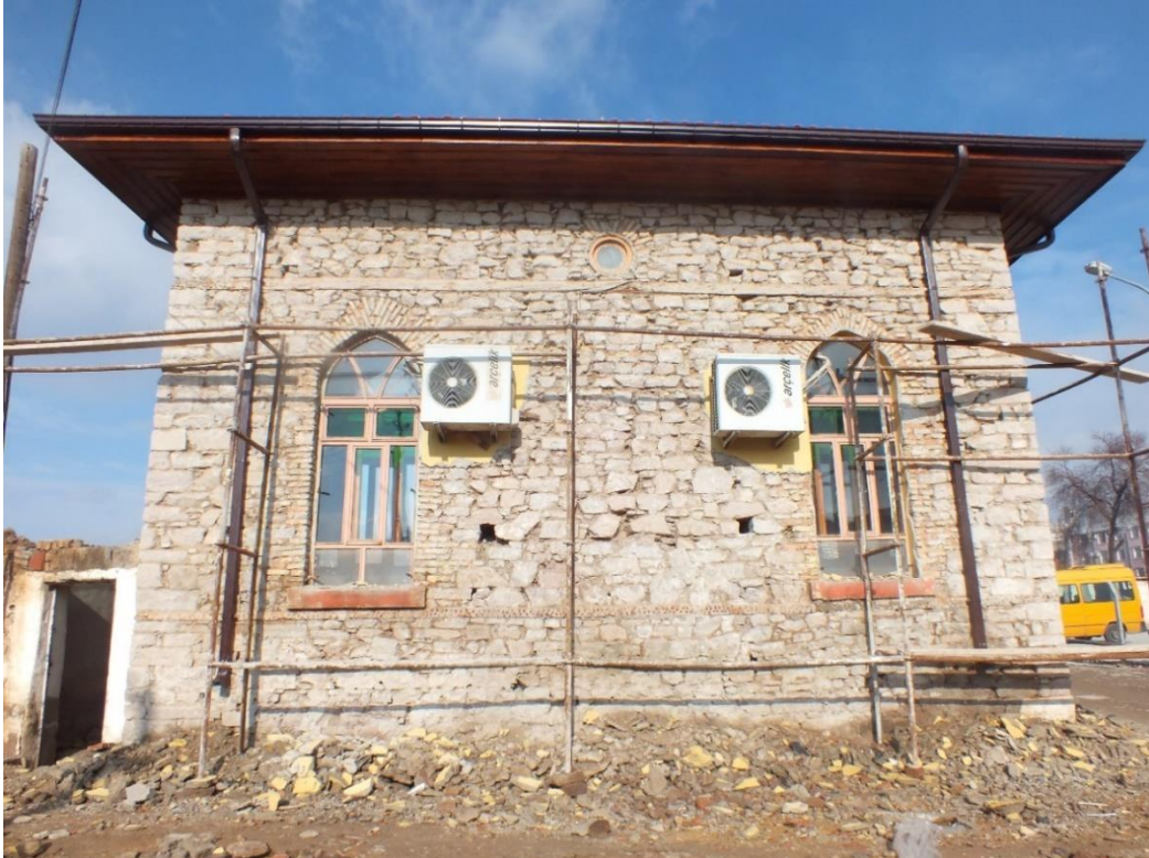
Fotoğraf 4: Hacı Ömerler Camii Güney Cephe Görünüşü.
