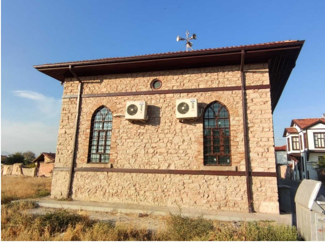
Fotoğraf 5: Hacı Ömerler Camii Güney Cephe Görünüşü.
